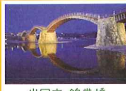
岩国市 錦帯橋
